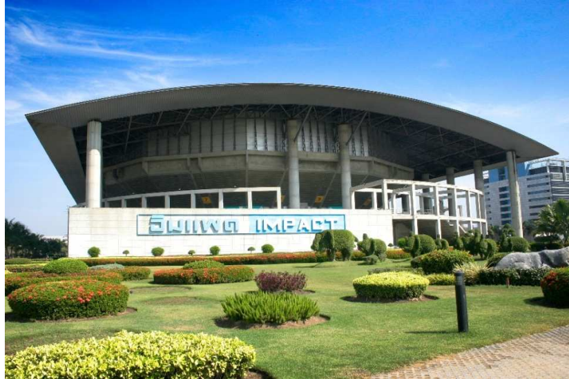
ภาพแสดงพื้นที่ภายนอกอาคารศูนย์จัดการแสดงอิมแพ็ค อารีน่า
