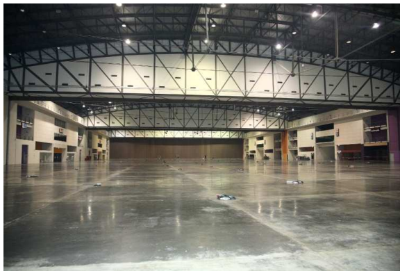
ภาพแสดงพื้นที่ภายในอาคาร 1 - 4
